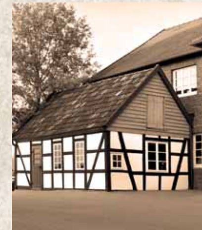
Das schicke Fachwerkgebäude von 1859 ist die Keimzelle von Düvel.
